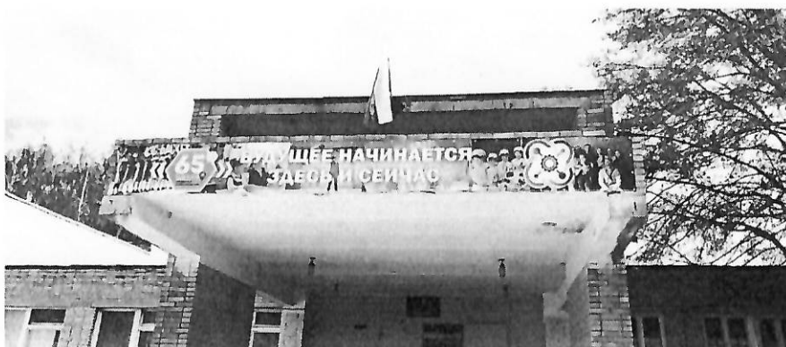
Вход в школу
